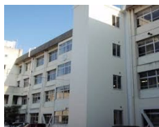
既設校舎に増築したエレベーター棟
