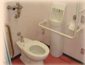
衛生的な多目的トイレの設置
