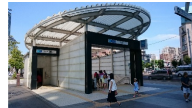
< 駅等における点字ブロックの連続的な整備(豊洲駅前) >
