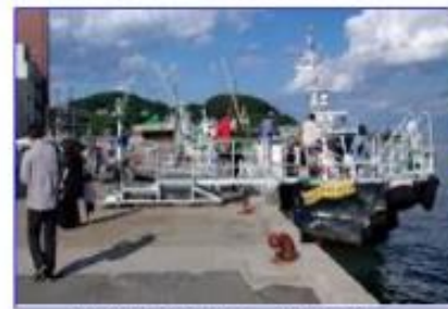
浮橋整備前の係留施設
