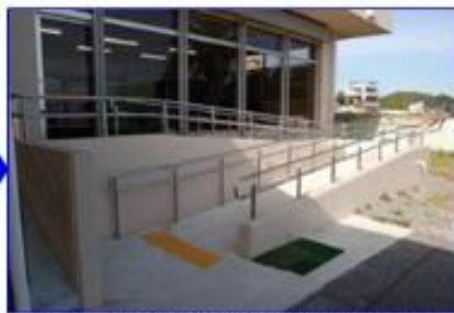
スロープ・手摺等が整備され、円滑な移動が可能である状態
