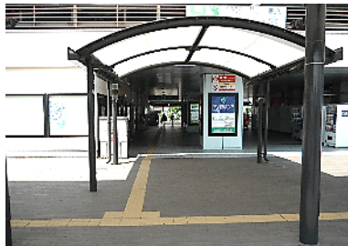
< 駅等における上屋、点字ブロックの連続的な整備 >
