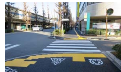
<歩道の整備(千駄ヶ谷駅周辺)>
