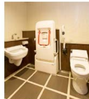
・壁掛け式大型ベッドのある 便所
