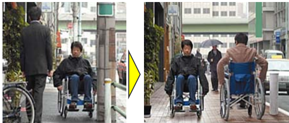
<歩道拡幅、無電柱化>
