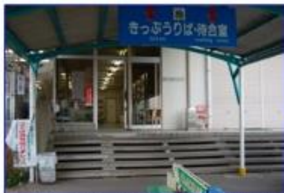
ターミナル入口にスロープ・手摺等が無く、円滑な移動に支障がある状態
