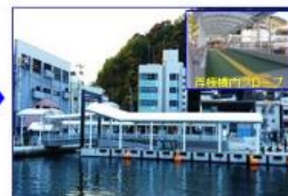
バリアフリーに配慮された浮桟橋
