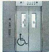
混雑時などに車椅子の方が優先的にご利用いただけます。音声案内・点字表示をし、低い位置に操作ボタンを付けました。
