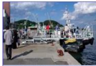
浮橋整備前の係留施設
