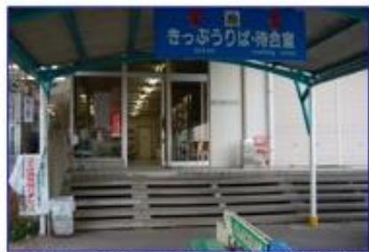
ターミナル入口にスロープ・手摺等が無く、円滑な移動に支障がある状態
