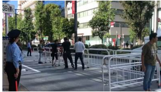
図 7 鉄柵の設置作業の様子
