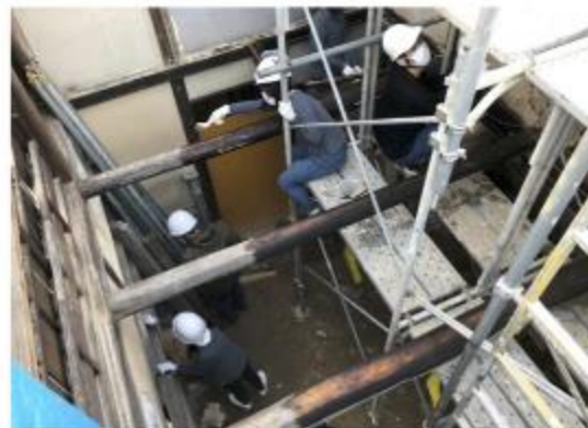
為房邸(防腐剤塗り作業)
