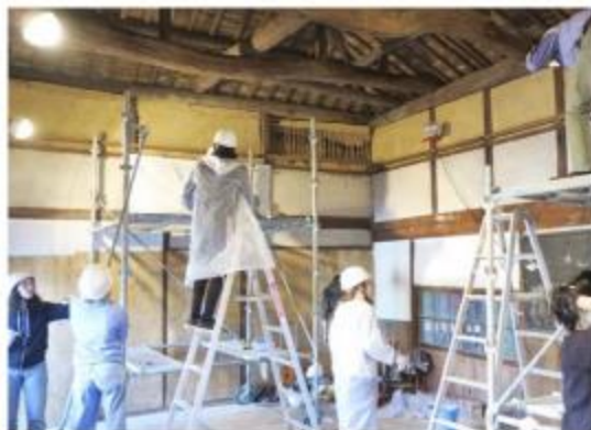
ミシン工場(梁上の補修)
