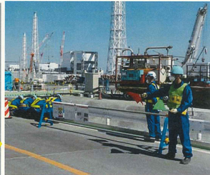
＜一般作業服での作業の様子＞
