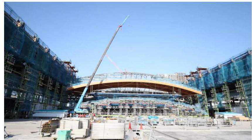
2018年9月 第1回リフトアップ工事の様子
