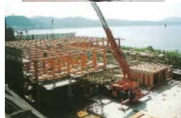
木格子の解体・運搬の様子
