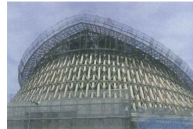
FSC認証材の集成材を構造に使った 静岡県立草薙体育館(建設中の様子)
