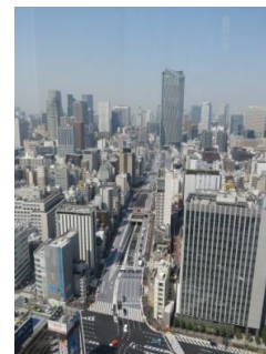
環状第2号線の整備
