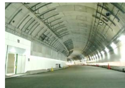
首都高速中央環状品川線 本線シールド 施設施工状況
