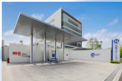
<水素ステーション>
