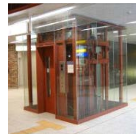
エレベーター (鉄軌道駅)
