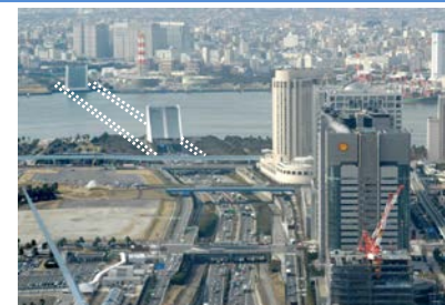
国道357号 東京港トンネル
