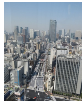
環状2号線の整備
