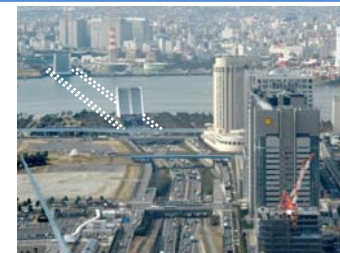
国道357号 東京港トンネル
