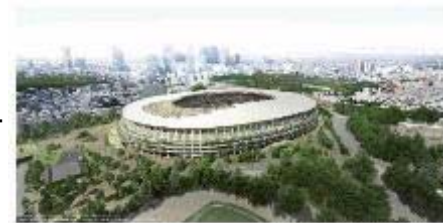
新国立競技場の建設状況(平成28年)
