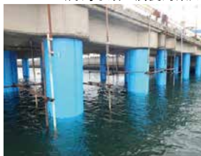
< 港湾施設の補修状況 (月島ふ頭の腐食対策) >
