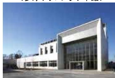
<多摩テクノプラザ本館>
