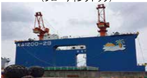
<インフラツーリズムの事例> (フローティングドック)
