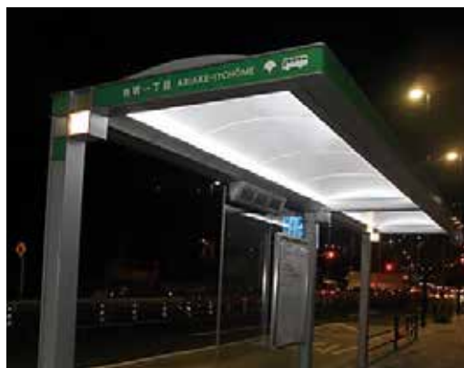
<LED照明付バス停留所>
