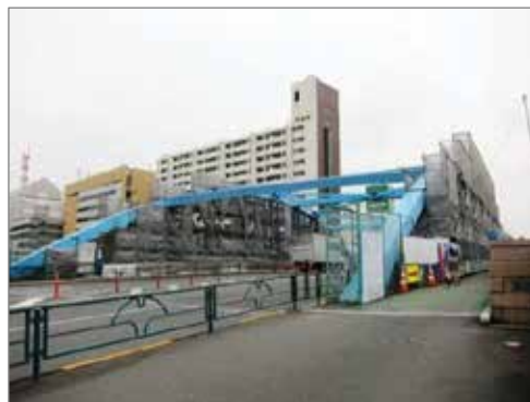
< 橋梁の長寿命化対策(蒲田陸橋) >
