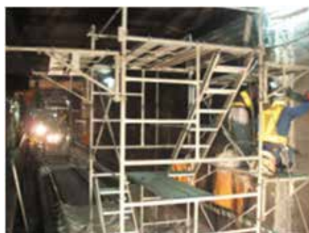
< 都営地下鉄の大規模修繕 >
