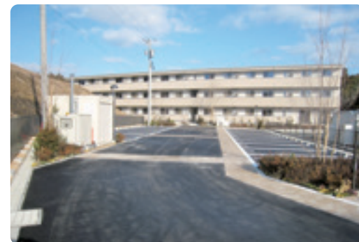
住まいの復興状況:建設が進む災害公営住宅
