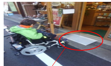
店舗への取り外し可能な簡易スロープの設置
