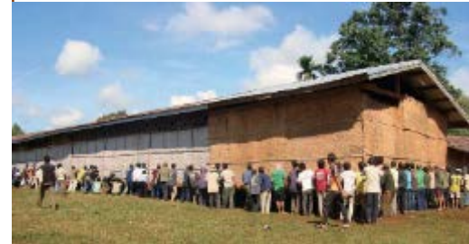
飯舘村の支援で建設された学校
