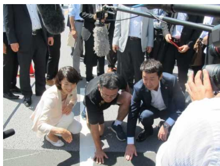
【舗装温度の確認】
