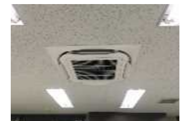
換気設備の導入
