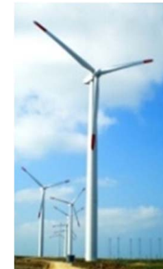
⑤大型風力発電 システム
