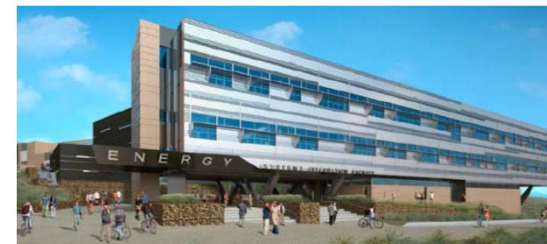
米国国立再生可能エネルギー研究所(NREL) 「Energy System Integration Facility (ESIF)」施設
