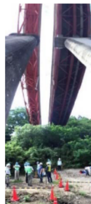
球殻ドローンを用いた橋梁の検査
