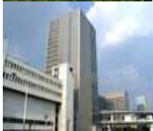
NTTテレパーク堂島第2ビル 堂島第3ビル (大阪市)
