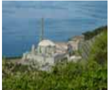
高速増殖炉もんじゅ建設所(敦賀市)核燃料サイクル開発機構
