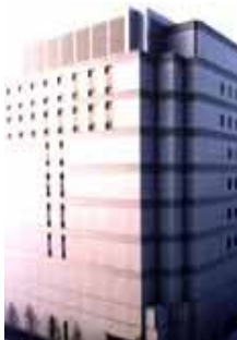
関西電力 データセンター他 (大阪市)
