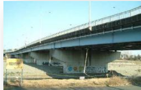
例:新浅川橋(橋梁点検)
