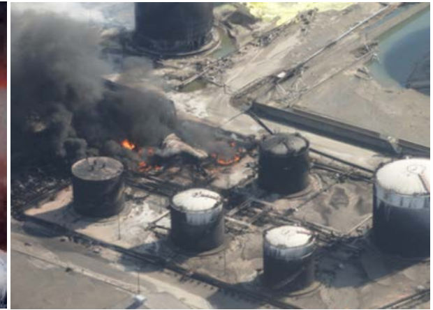
(屋外貯蔵タンクの火災)
