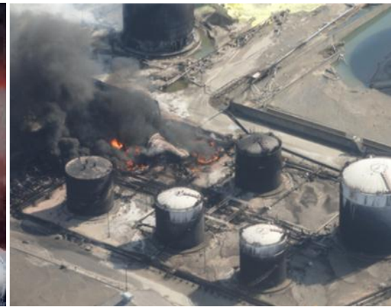
(屋外貯蔵タンクの火災)
