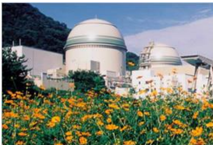
図7 高浜発電所<出典>関西電力株式会社
