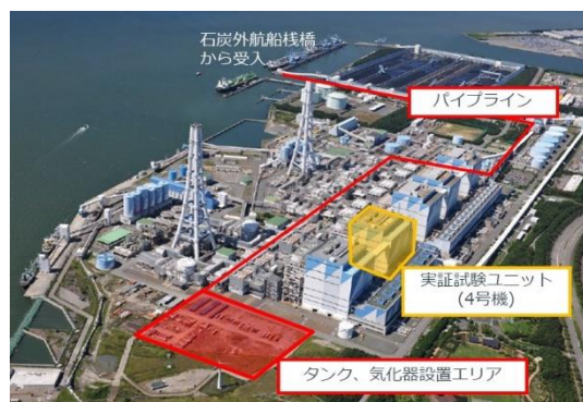
図9 碧南火力発電所におけるアンモニア混焼実証
