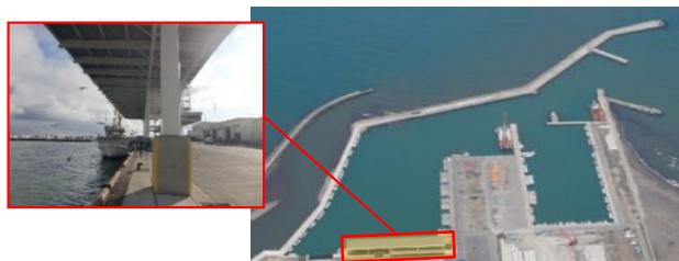
・衛生管理型屋根付き岸壁 } の整備 ・清浄海水導入施設
