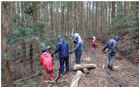
鳥獣被害防止柵設置の様子
