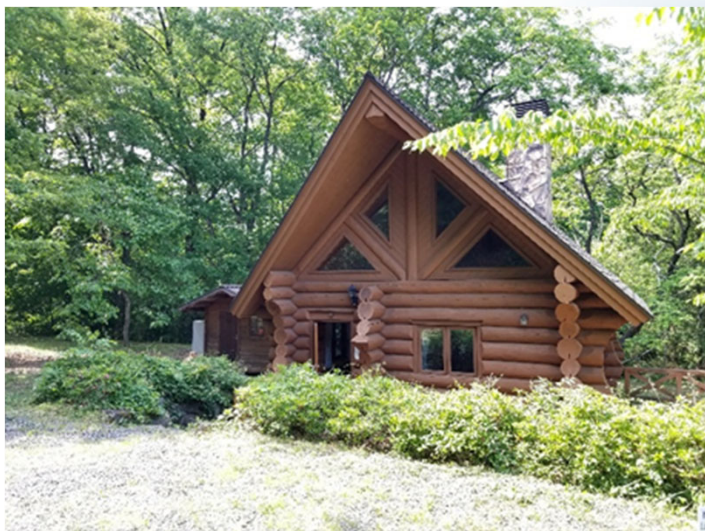
空き家を改修した宿泊施設
