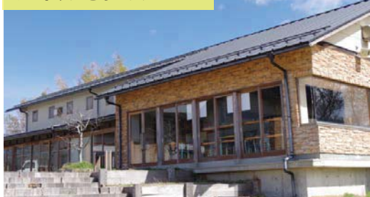
農場の一部施設を改修し、 レストランをオープン
