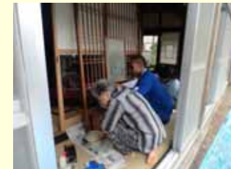
海外研修生と古民家再生作業
