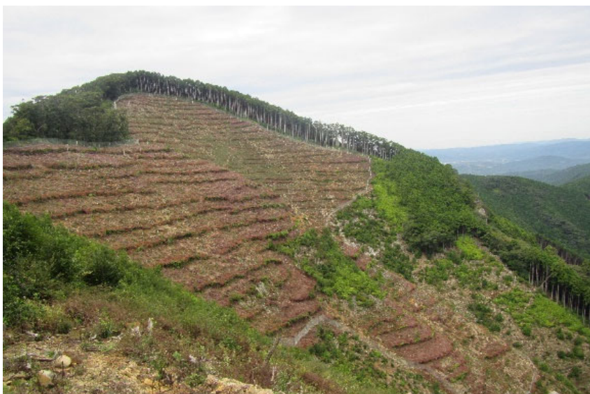
植栽完了現場写真
