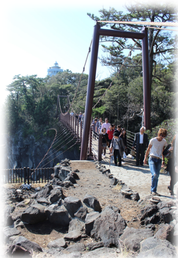
↑ 城ヶ崎 門脇吊り橋
