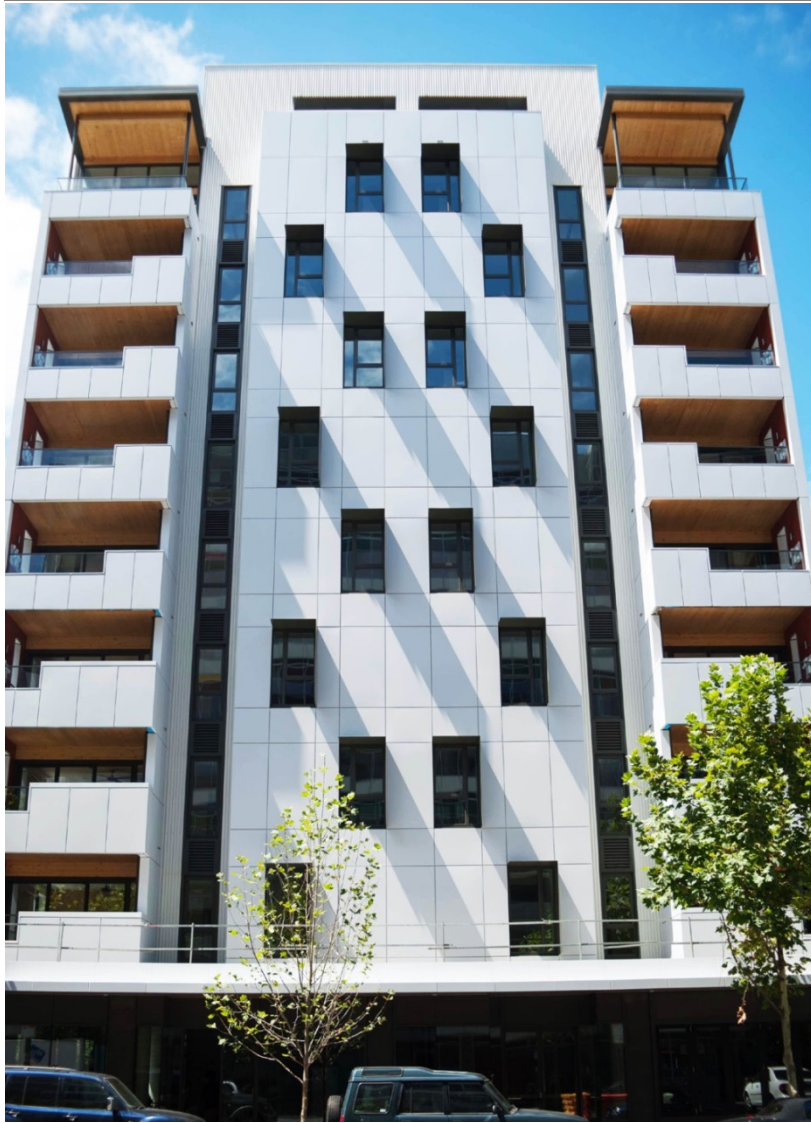
FORTE (メルボルン) 10階建 アパート (ただし1F部分はRC造)
