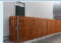
塗料を使用した外壁フェンス (四国局嶺北森林管理署)
