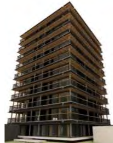
中高層建築物 (※建設中の鉄骨造+木造の混構造10階建て共同住宅)
