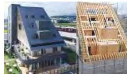
木造非住宅建築物 (※JAS構造材(2×4部材)を活用した商業ビル)
