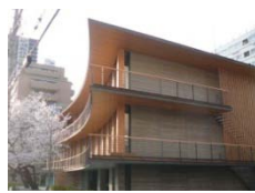
耐火建築物の事例
