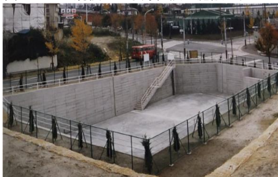
写真2-2 小規模な雨水貯留浸透施設の例
