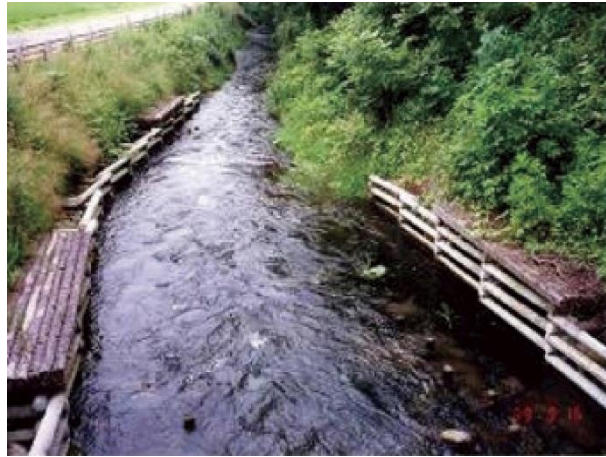
写真 3-2 環境との調和に配慮した排水路
