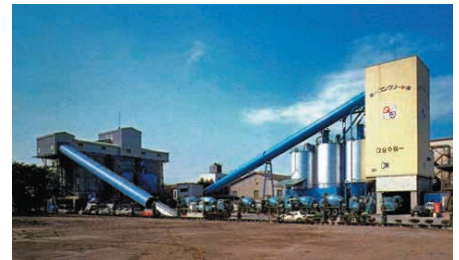
生コンクリート製造プラント
