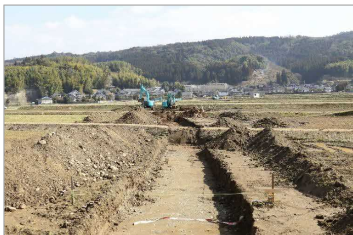
復旧工事（2017年2月）
