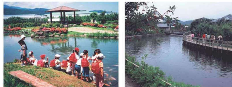
農業用水路と一体的に整備された親水施設(山形県寒河江市)
