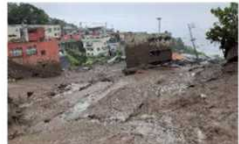
土石流による被害 (静岡県熱海市)
