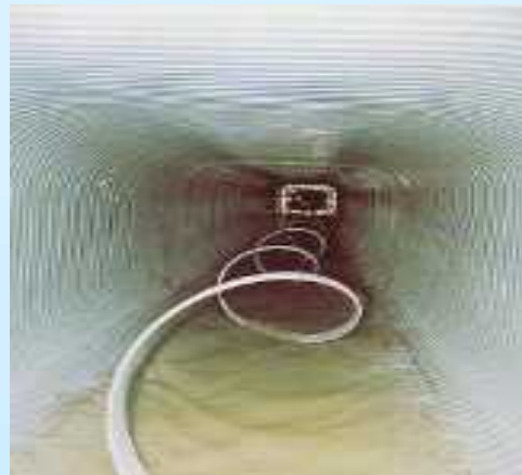
更生工法による長寿命化(下水道)
