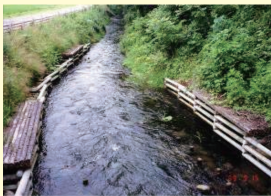
写真1-7 環境との調和に配慮した排水路
