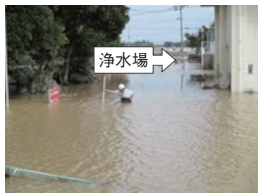
あいのや 常総市相野谷浄水場の浸水状況
