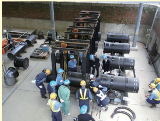
写真1-3 水道技術者のための配水管工技能講習会
