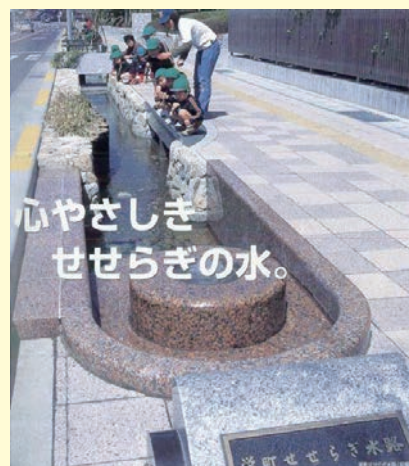
写真1-8 下水処理水（再生水）を利用した水辺空間の創出
