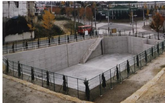
写真2-2 小規模な雨水貯留浸透施設の例
