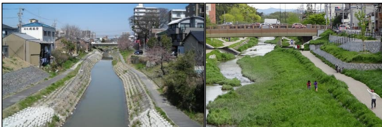
写真3-1 河床幅を確保し、寄せ土により滯筋の蛇行と多様な水際を創出
