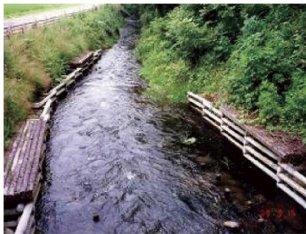
写真3-2 環境との調和に配慮した排水路
