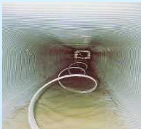
Aumento de la vida útil mediante la renovación (sistema de desagüe)
