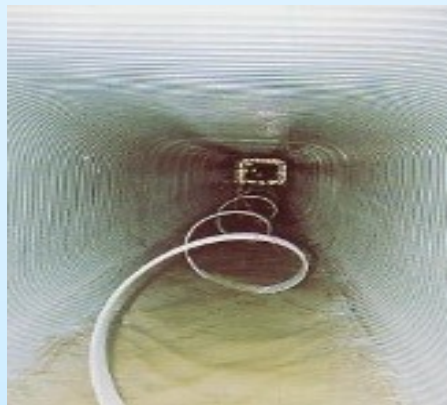
更生工法による長寿命化(下水道)
