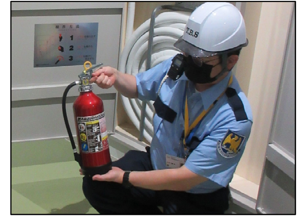
警備隊長による消火器の確認
